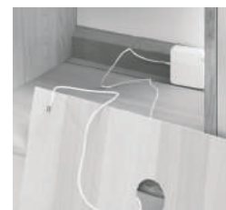
Løs bagklædning med huller til ledninger i modul: 158+222+232+233.
